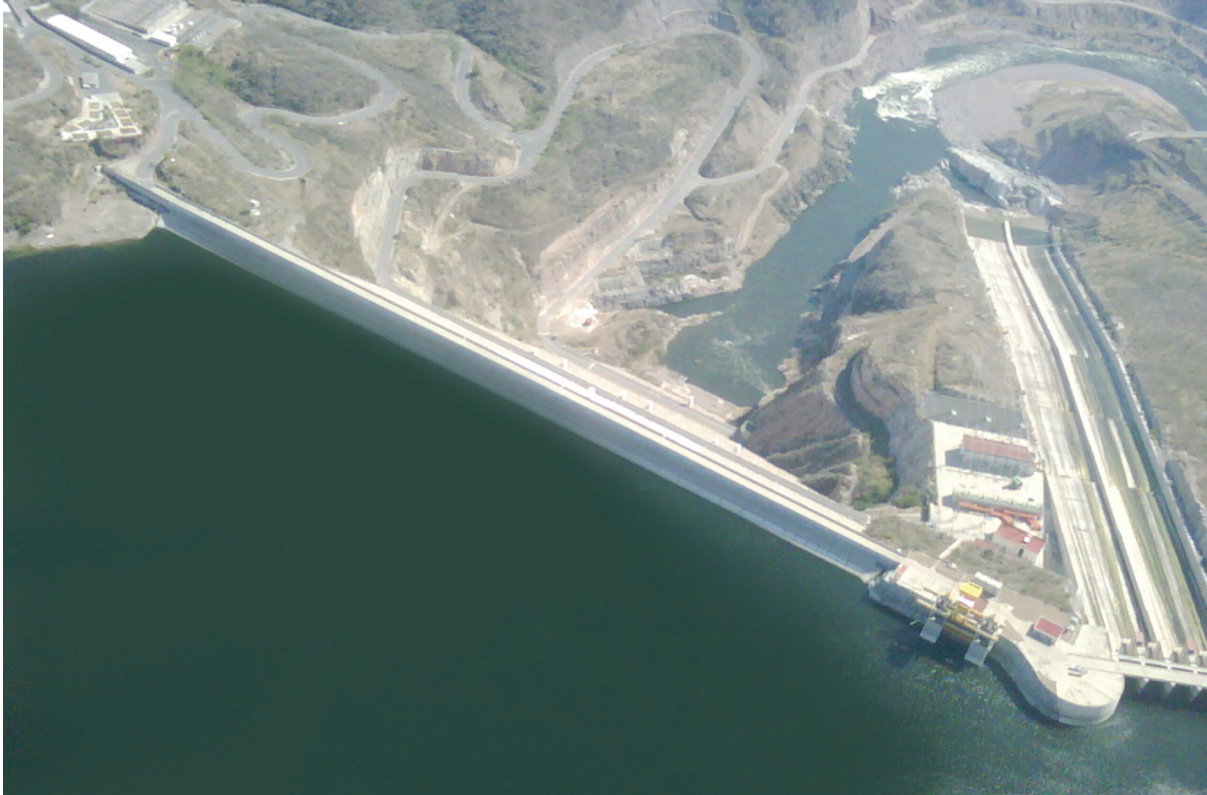
Comisión Federal de Electricidad, Proyecto Hidroeléctrico El Cajón, Santa María del Oro, Nayarit.
