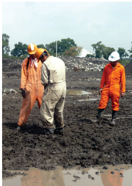
Zona afectada por residuos peligrosos.
